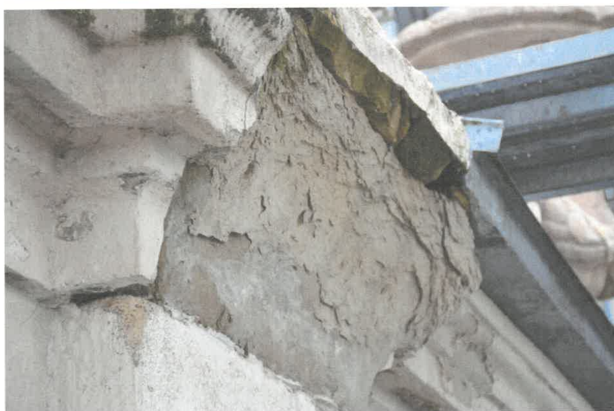
Fot. nr 3, 4. Detal architektoniczny kościoła pw. św. Wawrzyńca w Rymanowie. Widoczne na fotografii: silne spękanie detalu sztukatorskiego, ubytek kamienia dezintegracja strukturalna rozwarstwienia kamienia. Fot. Mariusz Wrona czerwiec 2024 r.
