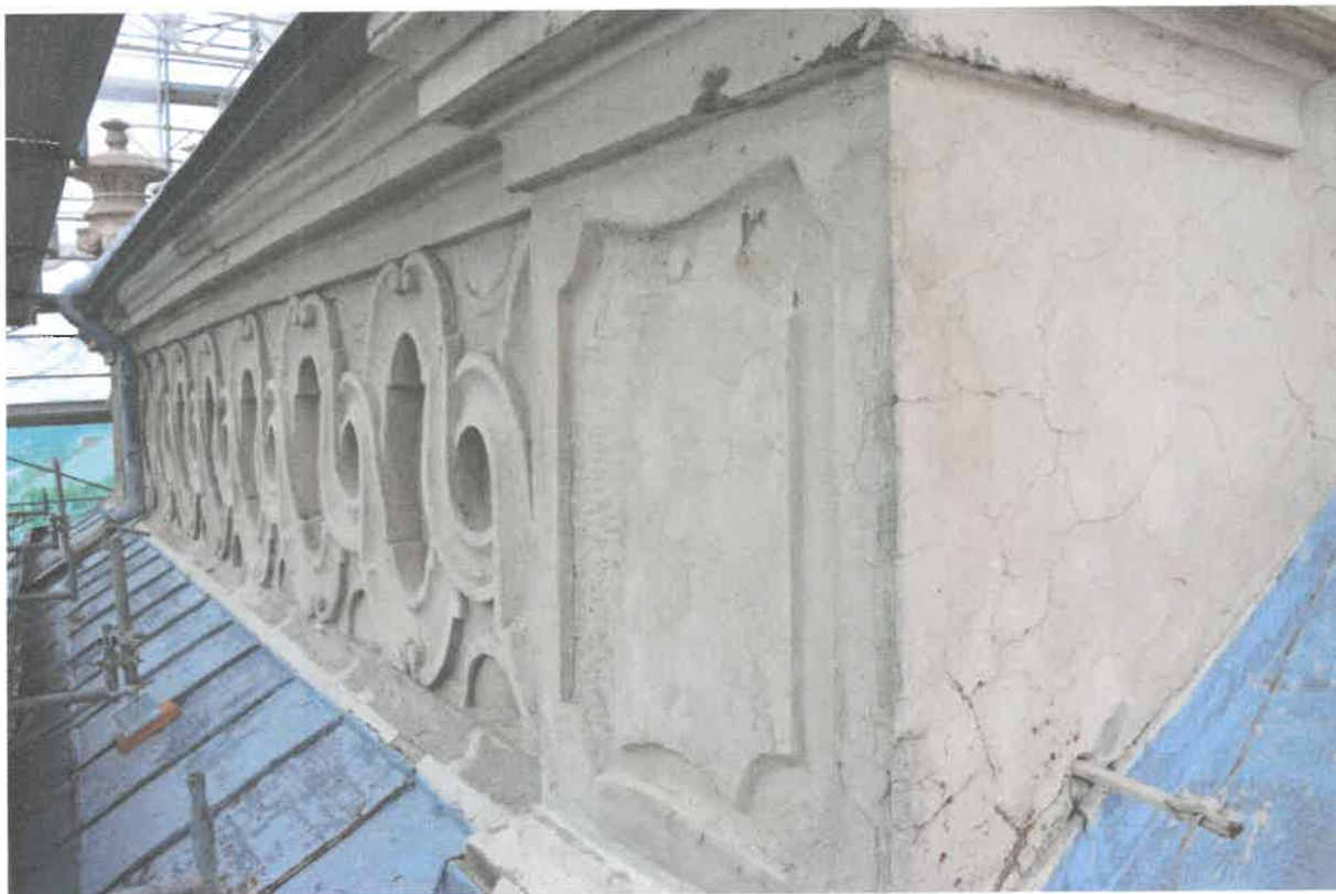
Fot. nr 1. Detal architektoniczny kościoła pw. św. Wawrzyńca w Rymanowie. Widoczne na fotografii: liczne nawarstwienia na powierzchni kamienia, przemalowania, ubytki formy rzeźbiarskiej.
